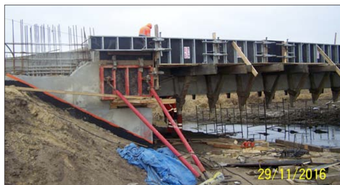
Przebudowa mostu na rzece Wschodniej w miejscowości Chałupki
