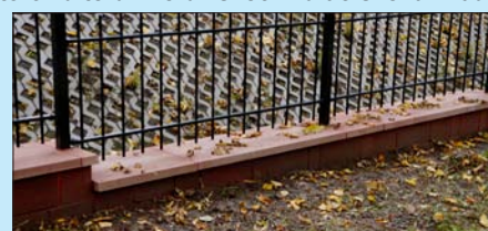
Wyremontowane ogrodzenie terenu szkoły
