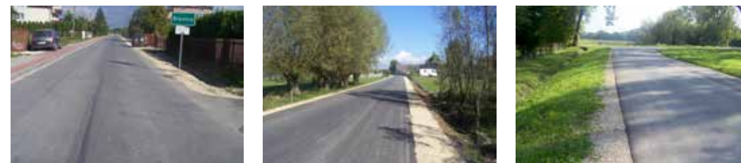
Wyremontowane drogi powiatowe w 2016 roku
