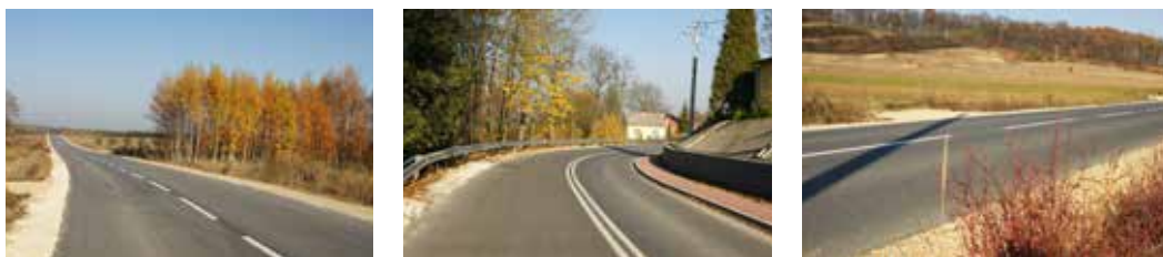
Droga powiatowa Skadla-Bronina
